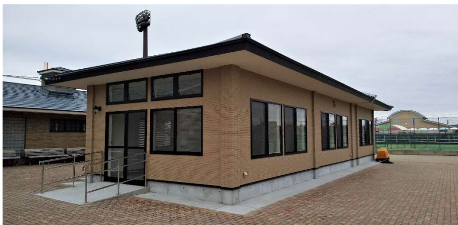
バリアフリー完備のクラブハウス
